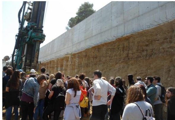
ΦΩΤ. 3. Κατασκευή συστοιχίας πασσάλων με ειδικό μηχάνημα διάτρησης εντός των κορηματικών υλικών και των νεογενών μαργαϊκών ιζημάτων για πασσαλότοιχο αντιστήριξης.
