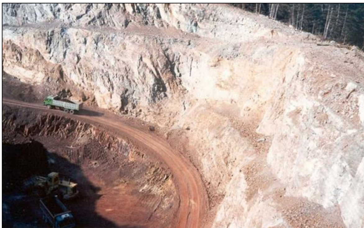
Εικόνα 2. Άποψη των εκσκαφών στη Μεταλλευτική Επαρχία Παρνασσού.
